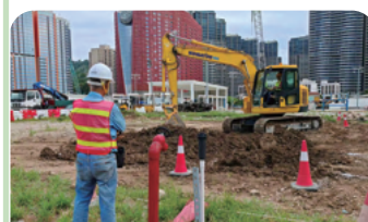
挖土機實操測試(實況)
